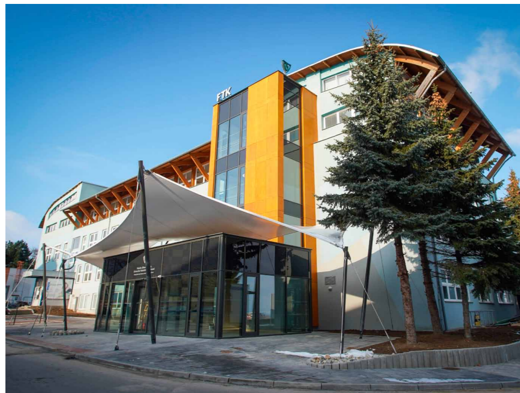
↑ Budova děkanátu fakulty tělesné kultury byla kompletně zrekonstruována.
