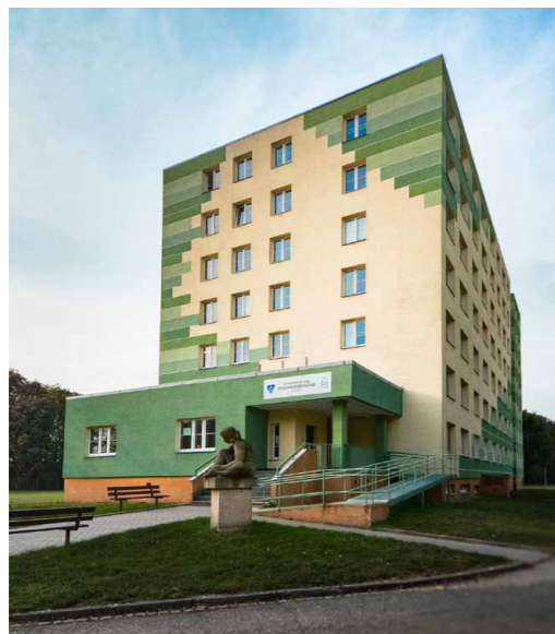
↑ Na koleji E. Rošického byly vybudovány dvě nové studovny.
